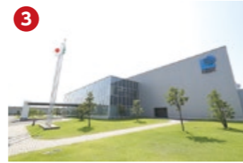
日本ガイシ NGK INSULATORS 日本ガイシ(株)石川工場
