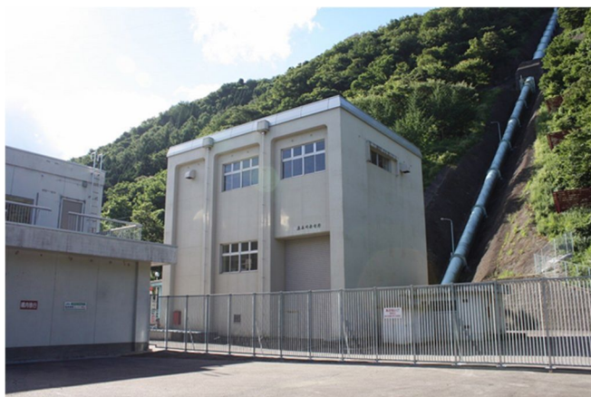
真名川発電所 本館
