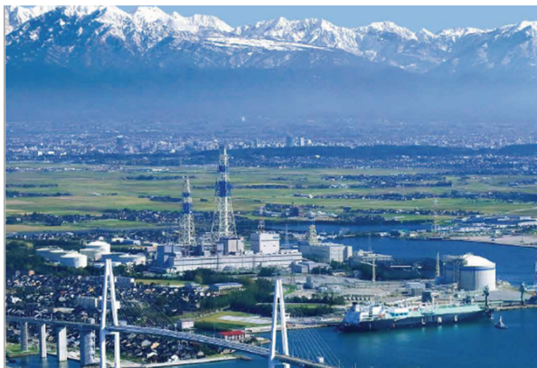
富山新港火力発電所
