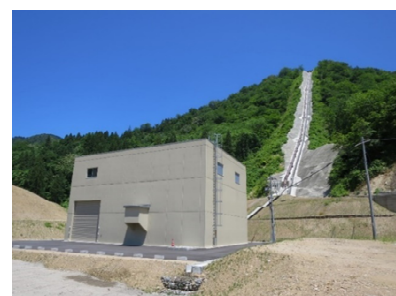
片貝別又発電所
