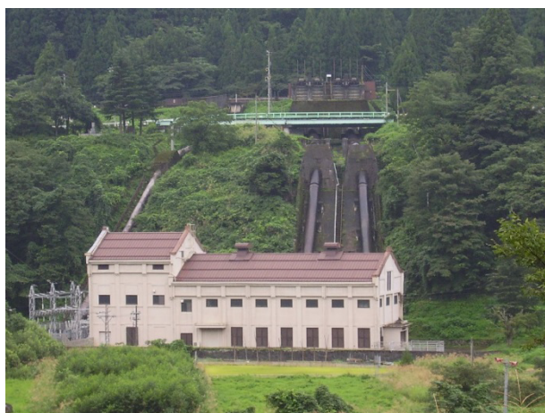
松ノ木発電所 全景
