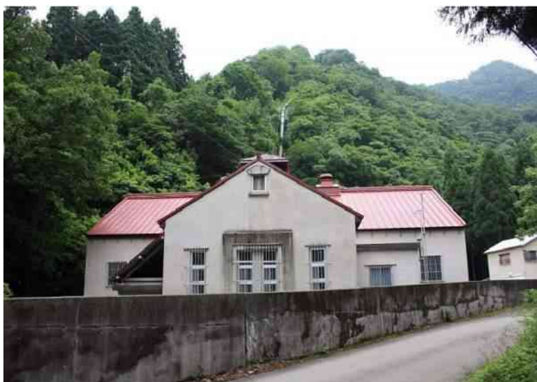
九谷発電所 本館
