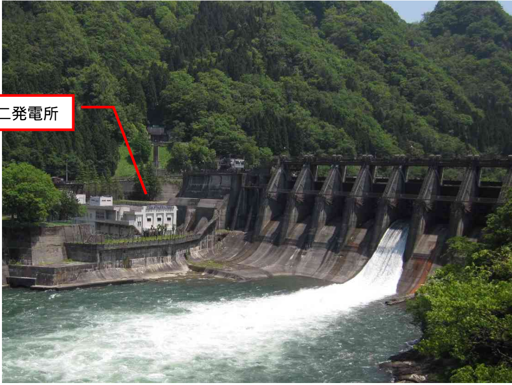
神二ダムおよび神通川第二発電所
