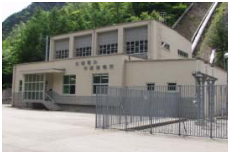
中崎発電所 本館
