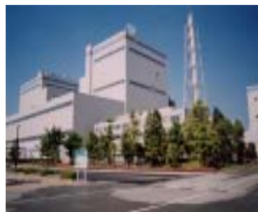
七尾大田火力発電所
