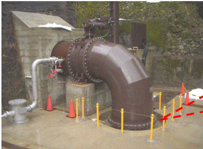
管路内にタービン発電機を据付
