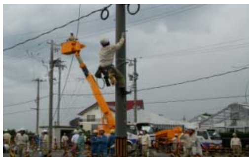
◆配電工事安全技能大会
