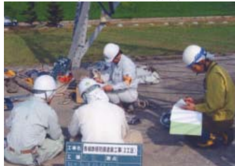
◆鉄塔塗装工事実施前の 施工者との作業手順確認
