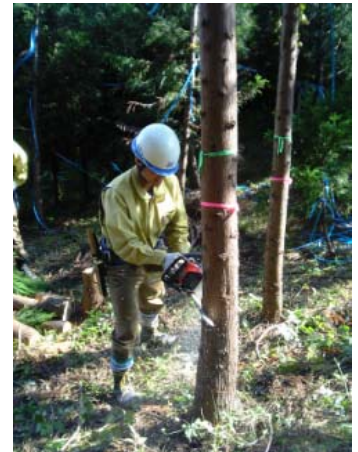
送電線下の樹木伐採
