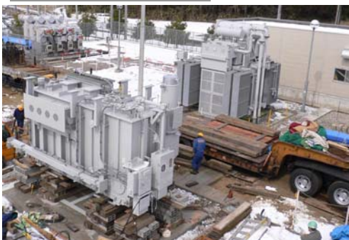
沖布変電所増強工事
