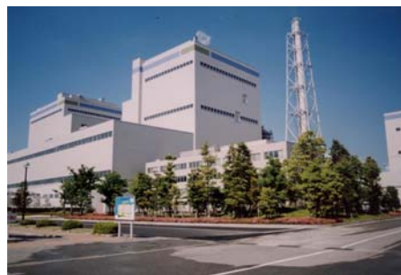
◆七尾大田火力発電所
