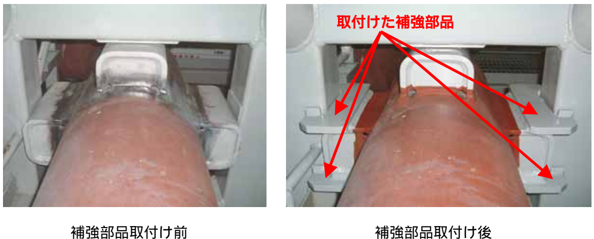
図 - 8 残留熱除去系配管支持構造物の補修状況
