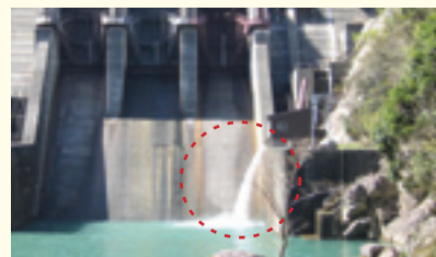
河川維持放流の状況（仏原ダム）
