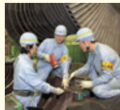
志賀原子力発電所 低圧タービン組立作業
