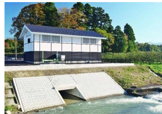
山田新田用水発電所(富山県南砺市) (北電技術コンサルタント(株)が調査・測量・設計)
