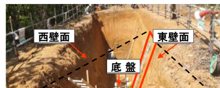
〔敷地外トレンチ調査〕
