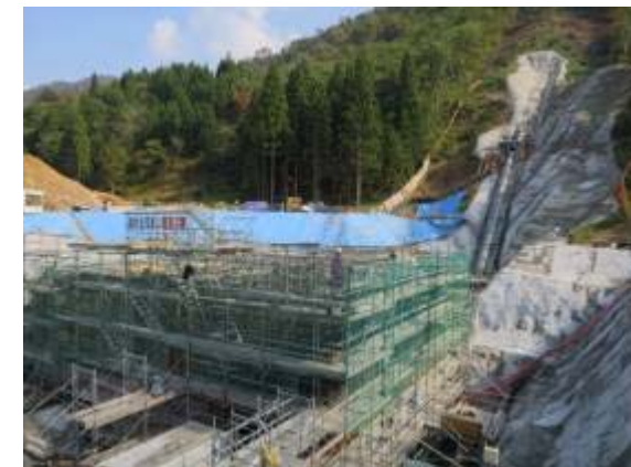
片貝別又発電所建設工事現場
