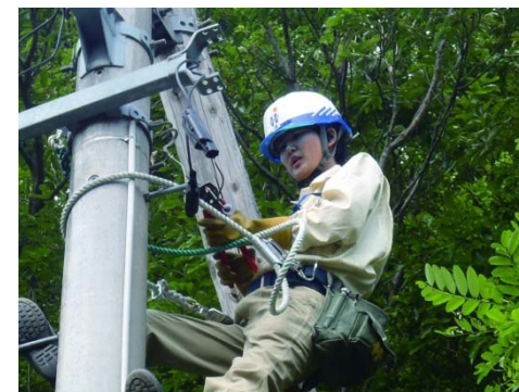
配電部門の女性従業員 (柱上での保守作業の様子)
