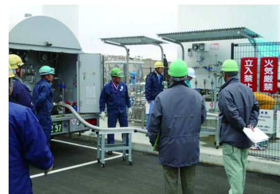
サテライト設備へのLNG荷卸作業
