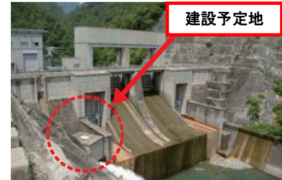
北又ダム発電所建設予定地
