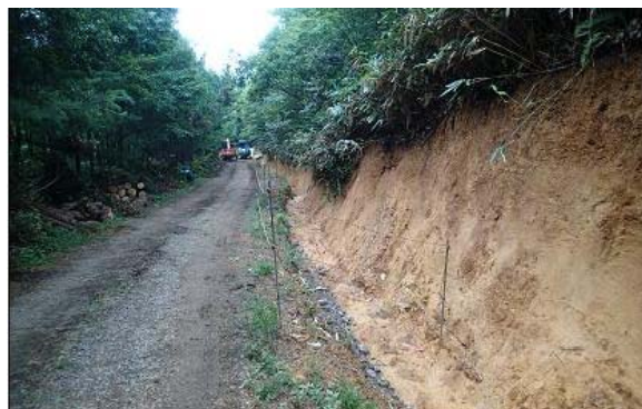
〔河床部の表土はぎ状況〕
