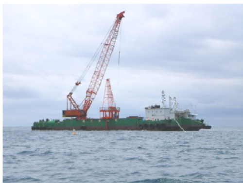
〔海上ボーリング調査状況〕
