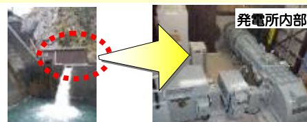
仏原ダム発電所
