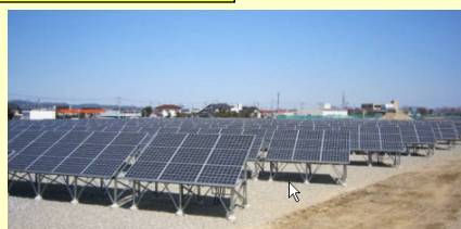
富山太陽光発電所
