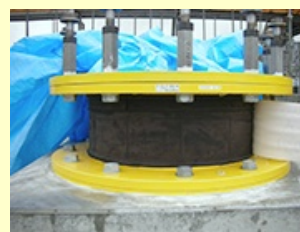
免震装置(積層ゴムアイソレータ)
