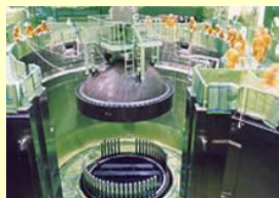
原子炉本体の点検
