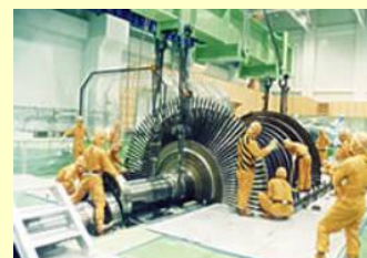
蒸気タービンの点検
