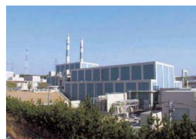
志賀原子力発電所 (奥:1号機, 手前:2号機)
