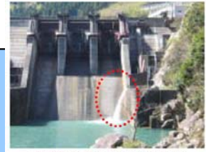
河川維持放流の状況(仏原ダム)
