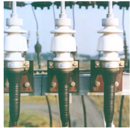
図 1 ケーブル端末用磁器がいし
