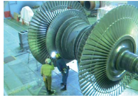
火力発電所定期点検の様子
