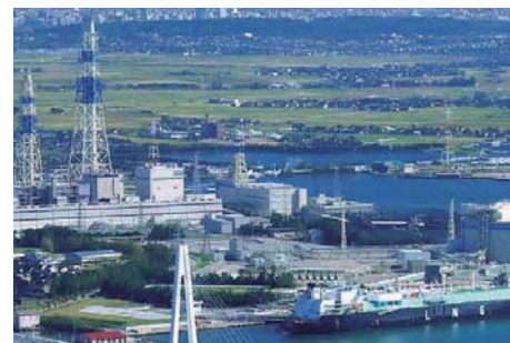
<2018年>富山新港火力発電所LNG1号機運用
