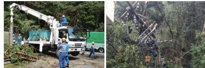
倒木処理、被害設備の撤去および電柱新設
