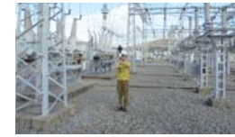
新技術活用による効率化 (360°カメラを活用した現場調査)
