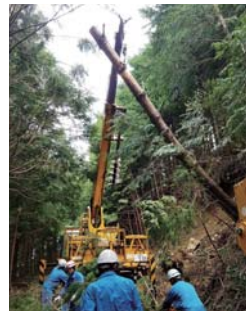
倒木処理、被害設備の撤去
