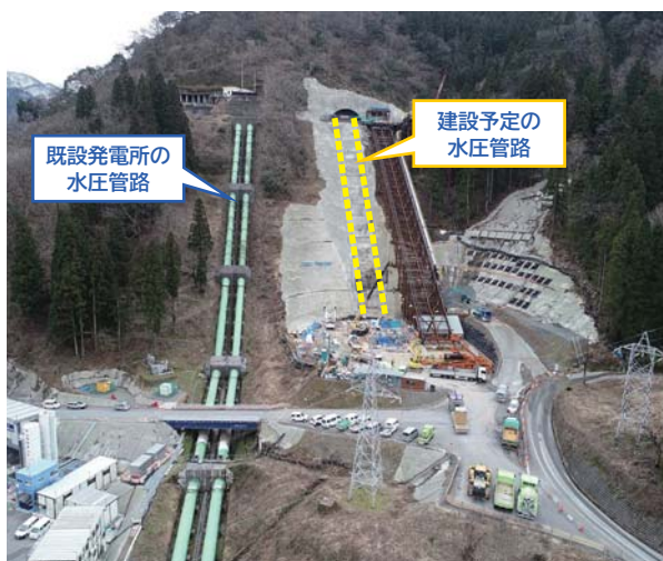
新姫川第六発電所の建設状況(2020年1月)
