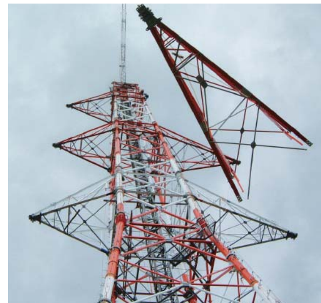
鉄塔組立工事
