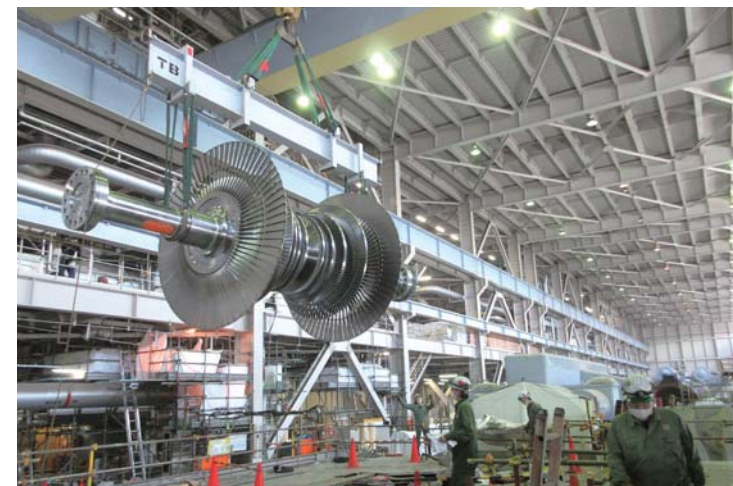
七尾大田火力2号機 定期点検時のタービン取替
