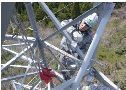
設備延命化に向けた鉄塔の塗装
