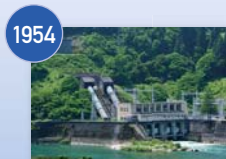
1954 神通川第一発電所(水力)
