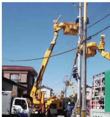
コンクリート柱の建替工事
