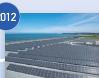
2012 三国太陽光発電所
