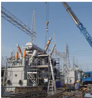
大型変圧器更新工事
