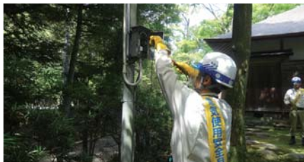
国指定重要文化財「江沼神社長流亭」の電気設備点検
