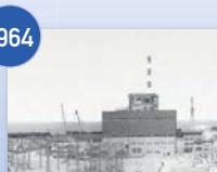
1964 富山火力発電所1号機
