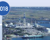
2018 富山新港火力発電所LNG1号機
