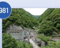
1981 有峰第一発電所(水力)
