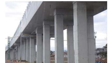
北陸新幹線高架橋
