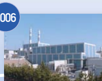
2006 志賀原子力発電所2号機
