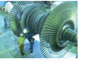
火力発電所定期点検の様子
