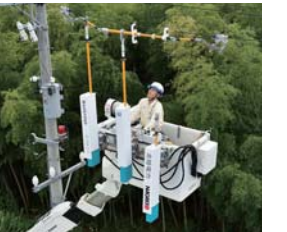
電線切断接続作業の様子
