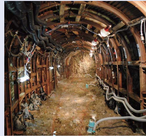
岩盤調査坑(横坑)
