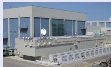
増築した指揮エリアの外観
