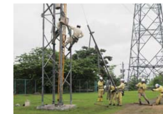
鉄塔損壊や電線断線等を想定した仮鉄柱の組立訓練
