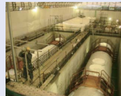
地下式軽油タンクの設置
