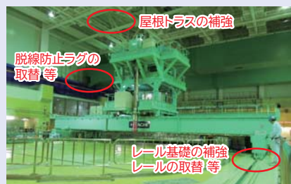
耐震安全性向上工事
