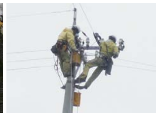
柱上での復旧作業
