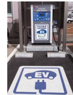
急速充電装置(小松支社)
