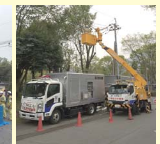
高圧発電機車の取付作業
