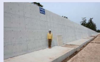
防潮堤の設置
