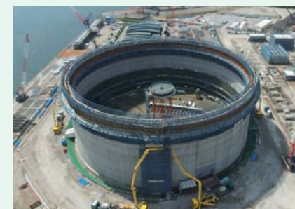
LNGタンク工事
