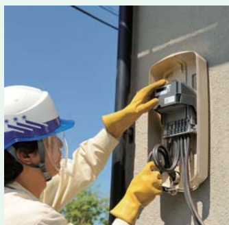
スマートメーター設置の様子
