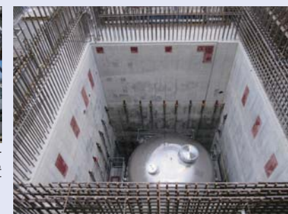
本体装置の搬入・据付(2015年7月)
