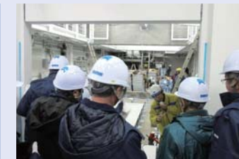
現地見学会の様子 （緊急時対策棟増築工事状況）
