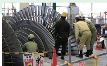
敦賀火力発電所2号機定期点検
