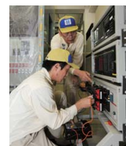
変電所での点検
