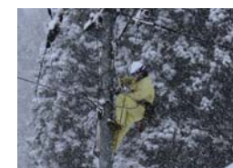
厳冬期での断線復旧訓練
