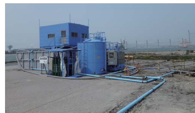
仮設排水処理装置の設置状況
