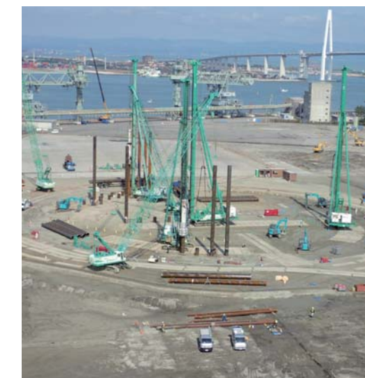
LNGタンク基礎杭打設状況
