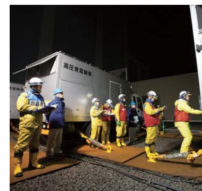
夜間の電源接続訓練
