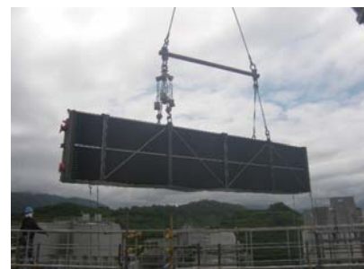
ガスガスヒーター更新(敦賀火力発電所2号機)
