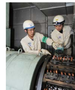
火力発電所での巡視点検
