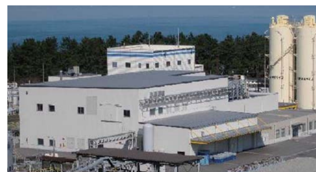
変圧器リサイクルセンター
