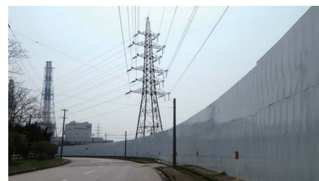
仮設防音壁の設置状況
