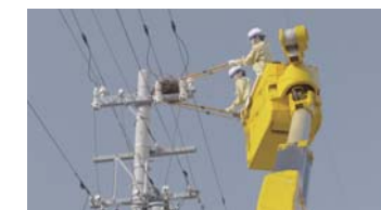
営業撤去作業
