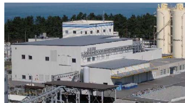
変圧器リサイクルセンター
