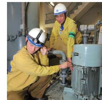
水力発電所での巡視点検
