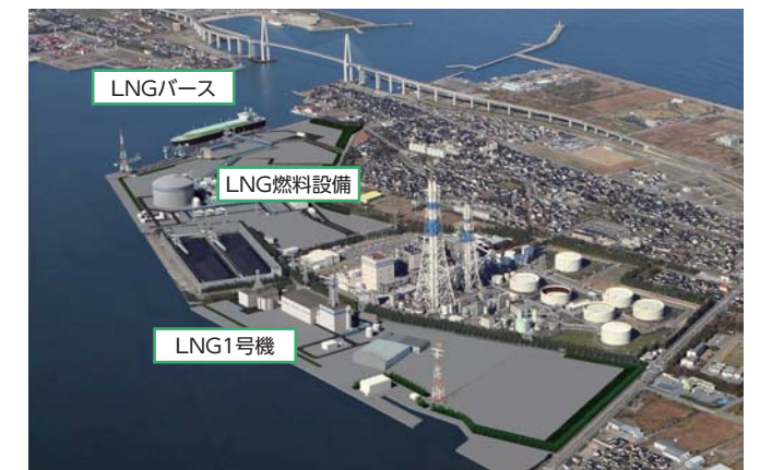
富山新港火力発電所LNG1号機イメージ図
