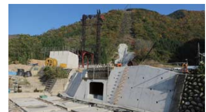
片貝別又発電所建設工事現場
