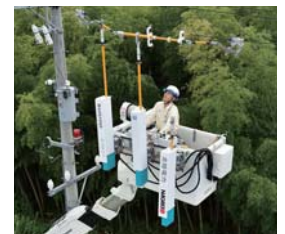
電線切断接続作業の様子
