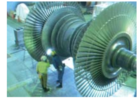
火力発電所定期点検の様子
